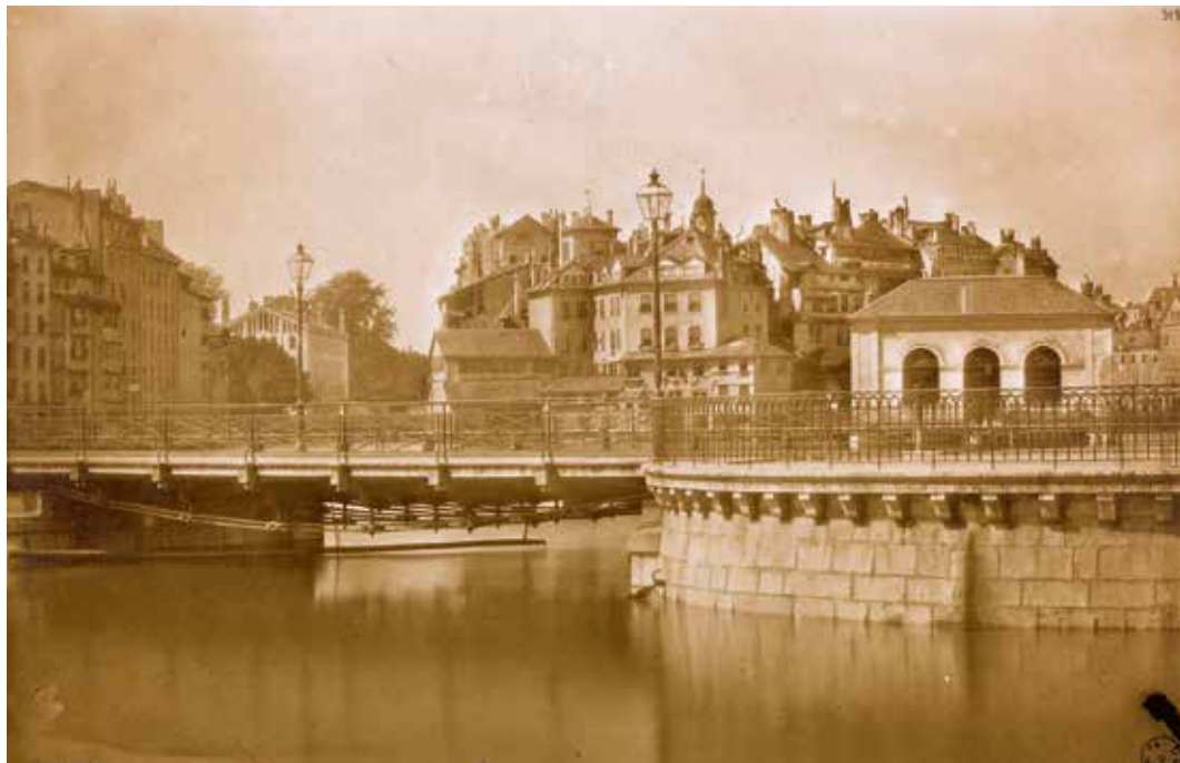
Pont des Bergues mit gusseisernen Ketten als Tragkonstruktion, um 1860.
